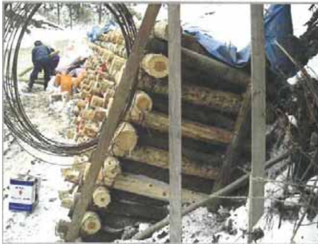
端部施工状況
