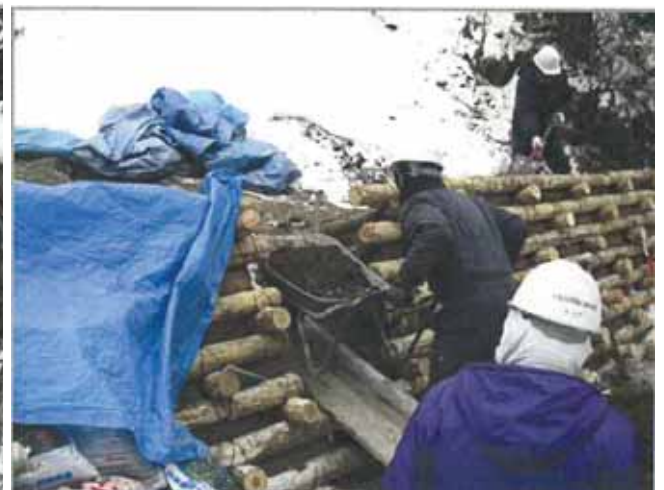
背面盛土状況
