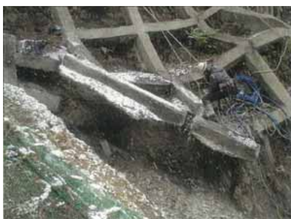
<法枠工撤去状況>
