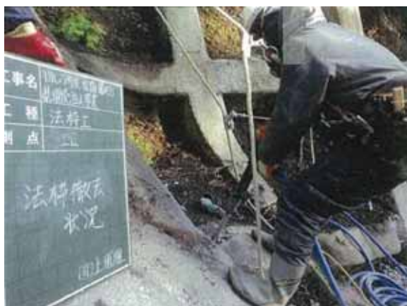
<法枠工撤去状況>
