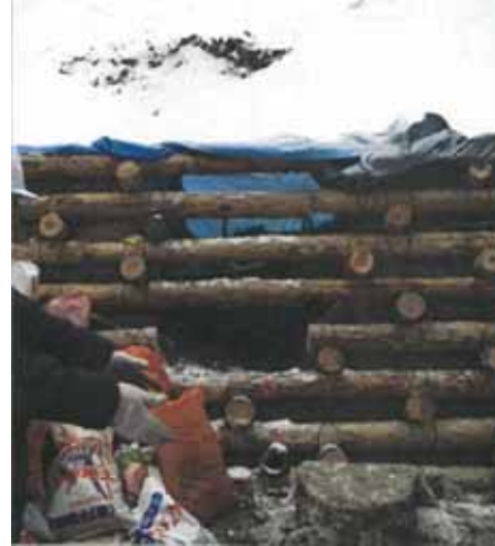
水路工吐口部施工状況
