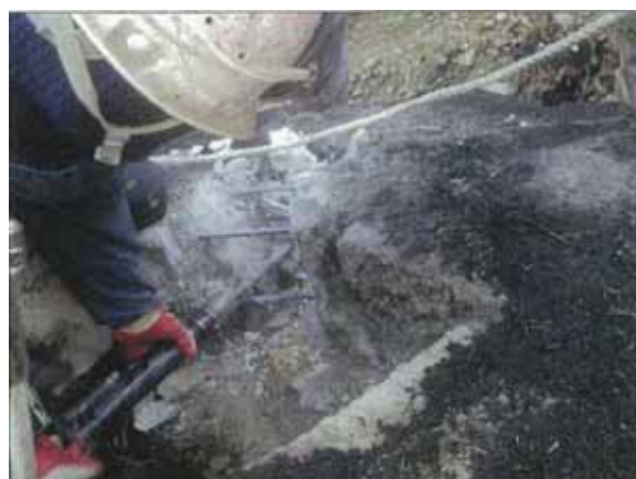
<法枠工撤去状況>
