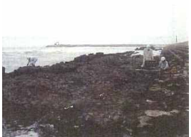
袋詰玉石設置
