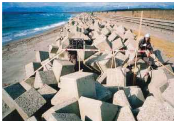
《施工状況（測量時）》
