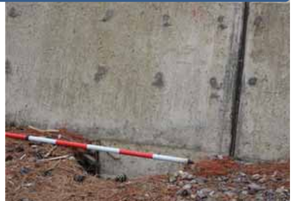
《対策実施前（損傷状況）》（左：基礎部の損傷、右：背面の吸出し）
