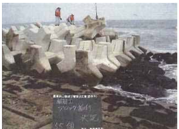
根固ブロック設置
