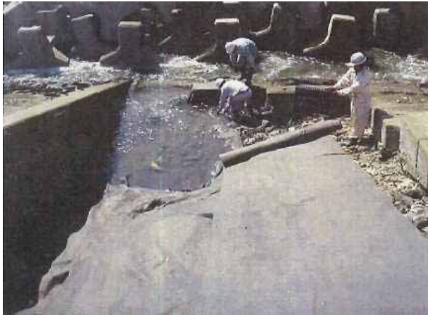
護岸ブロック設置（吸出し防止シート敷設）
