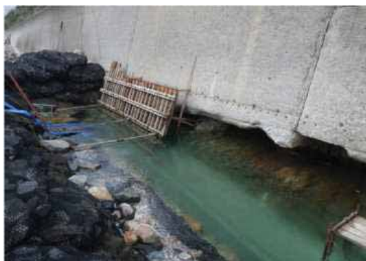
《施工状況》（左：基礎部根固工、右：背面土砂の埋戻し）
