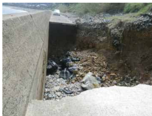
《対策実施前（損傷状況）》（左：基礎部の損傷、右：背面の吸出し）
