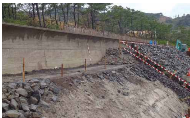
ブロック設置状況
