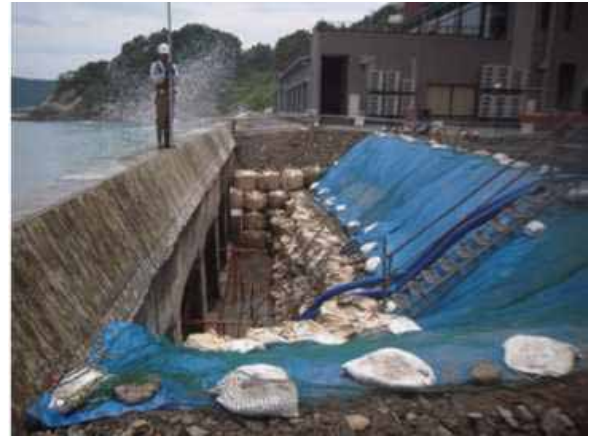
《施工状況》（左：基礎部の補修、右：背面の土砂埋戻し）
