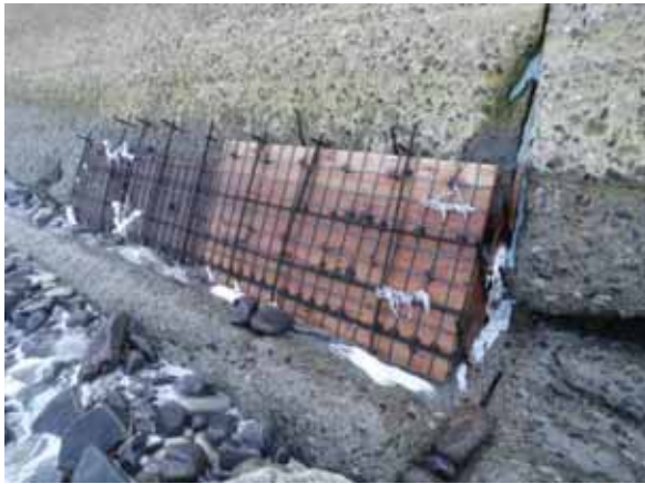
《施工状況》（左：基礎部の補修、右：背面の土砂埋戻し）
