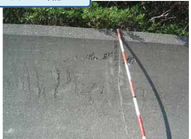
《対策実施前（損傷状況）》（左：堤体、右：波返工）
