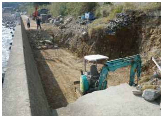
《施工状況》（左：基礎部根固工、右：背面土砂の埋戻し）
