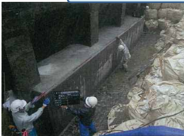
《施工状況》（基礎部のコンクリート充填状況）
