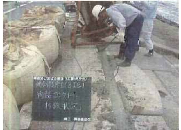
護岸ブロック設置（間詰打設）
