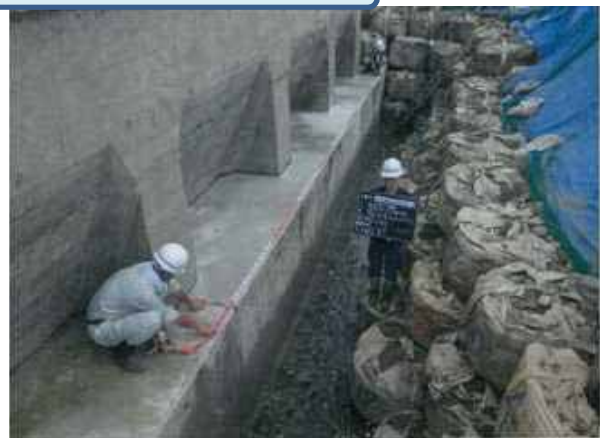
《施工状況》（基礎部のコンクリート充填状況）
