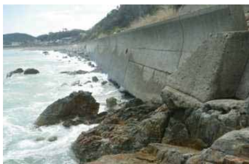
《対策実施前（損傷状況）》（左：基礎部の損傷、右：背面の吸出し）
