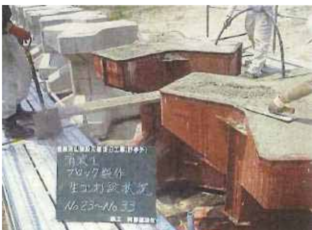
根固ブロック製作
