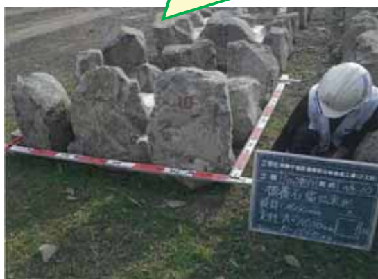
ブロック製作状況 (N=243 基)
