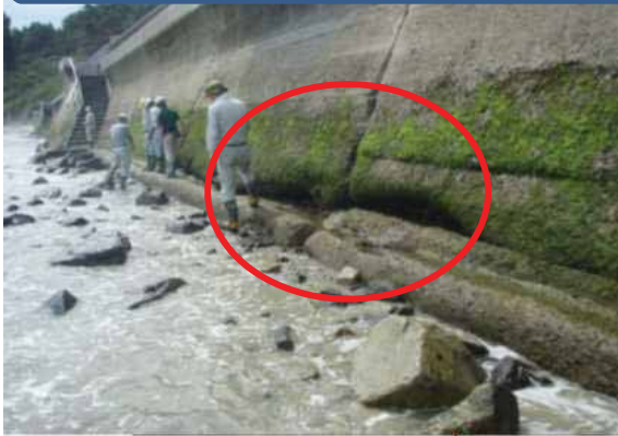
《対策実施前（損傷状況）》（左：基礎部の損傷、右：背面の吸出し）
