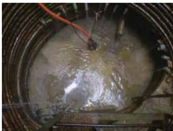
《対策実施前》 (左：集水井内の状況、右：排水ボーリング工 (吐口) の状況)
