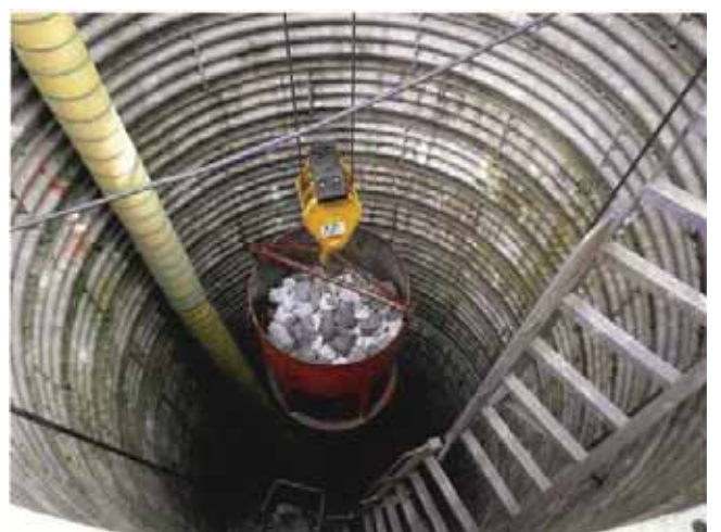
《施工状況》（左：排水ボーリング削孔、右：詰石実施）
