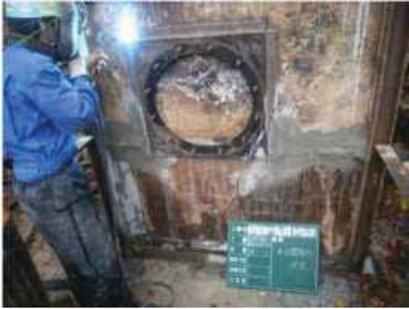
《大口径排水ボーリングの施工状況》
