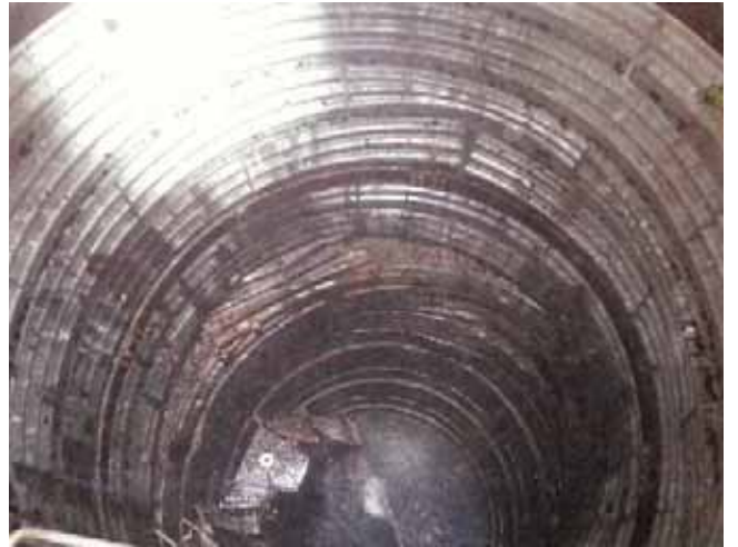
《対策実施前》（左：湛水状況、右：ポンプ排水後（下部埋設及び屈曲発生確認））
