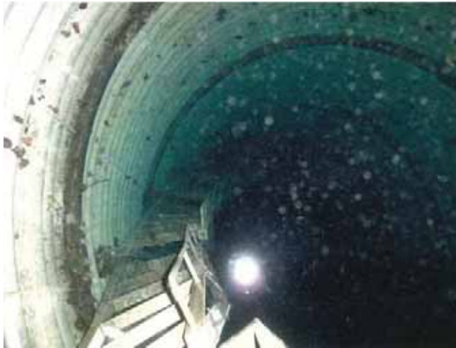
《対策実施前》（左：湛水状況、右：ポンプ排水後（下部埋設及び屈曲発生確認））
