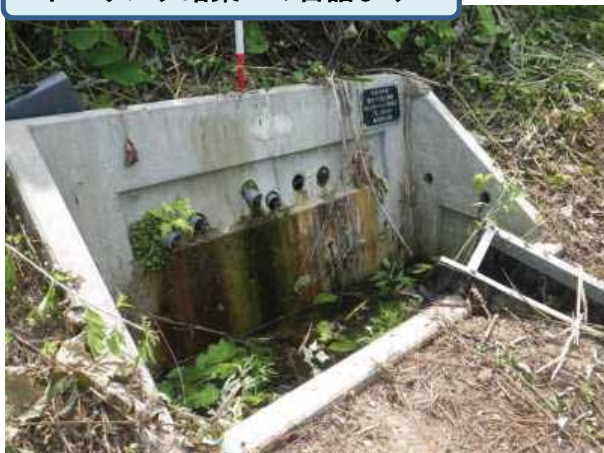
《対策実施前（損傷状況）》
