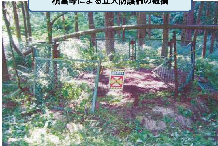
《対策実施前（損傷状況）》
