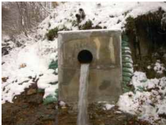
《対策実施後（大口径排水ボーリング（吐口））》
