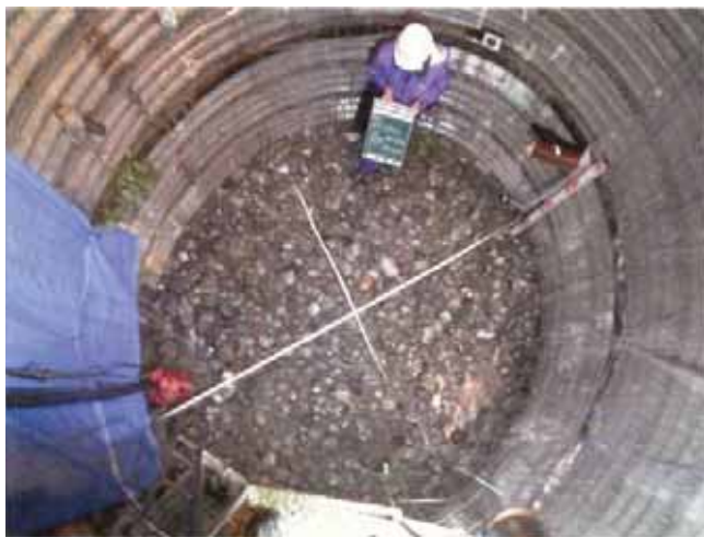
《施工状況》（左：詰石完了、右：静水層再打設）
