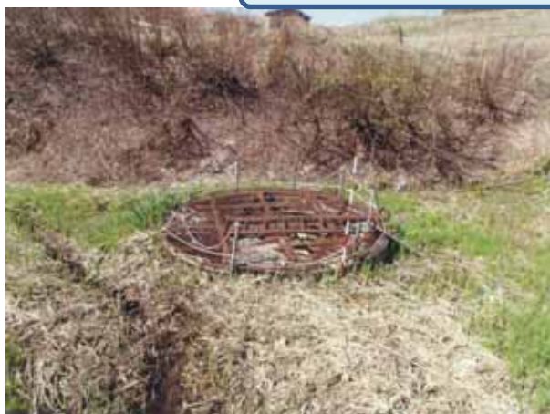
《対策実施前（損傷状況）》
