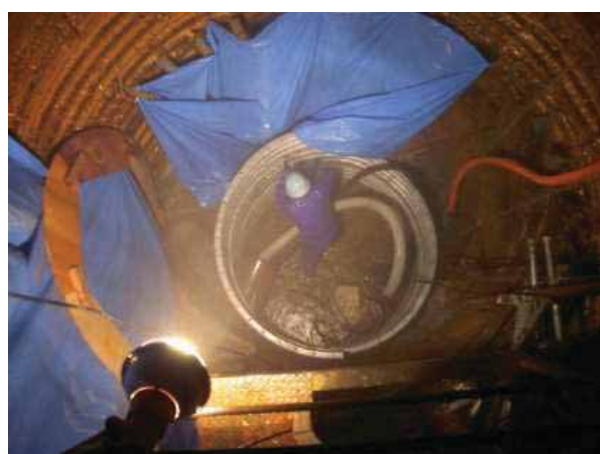
《集水井改修の施工状況》
