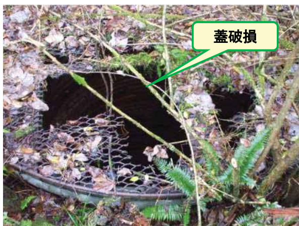
《対策実施前（損傷状況）》
