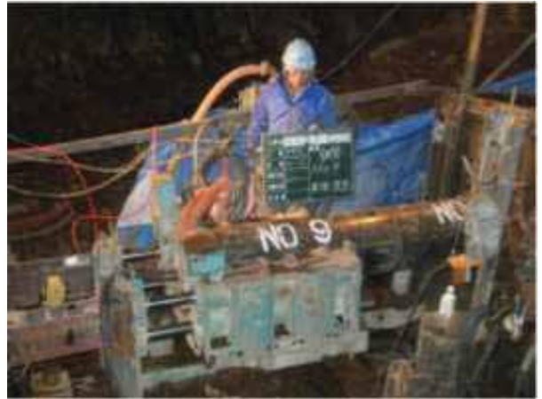
《大口径排水ボーリングの施工状況》
