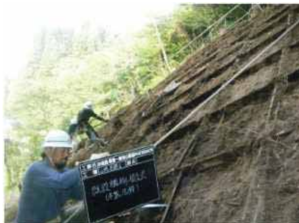
《施工状況（木製法枠工撤去）》
