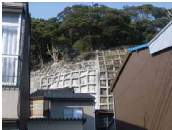
既設上にロックボルト、法枠、ファイバー入り吹付工設置
