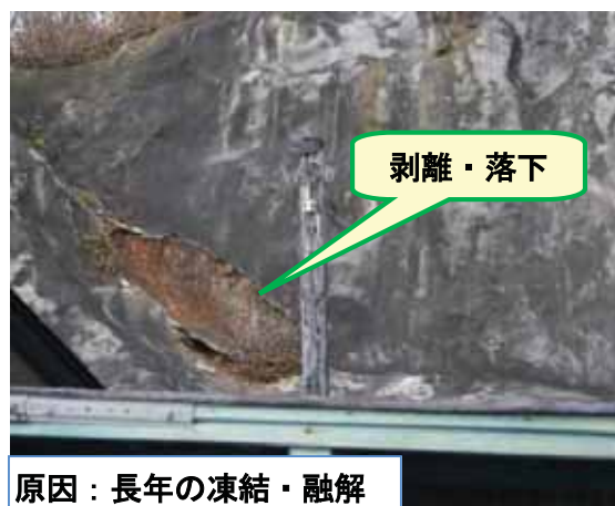
《対策実施前（損傷状況）》
