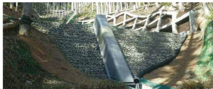
既設前面に土留工を新設
