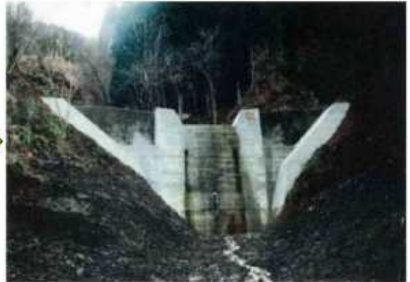
増厚・根継ぎ施工
