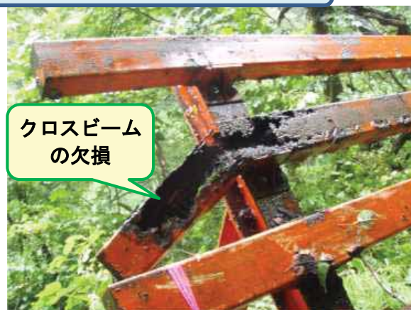
《対策実施前（損傷状況）》
