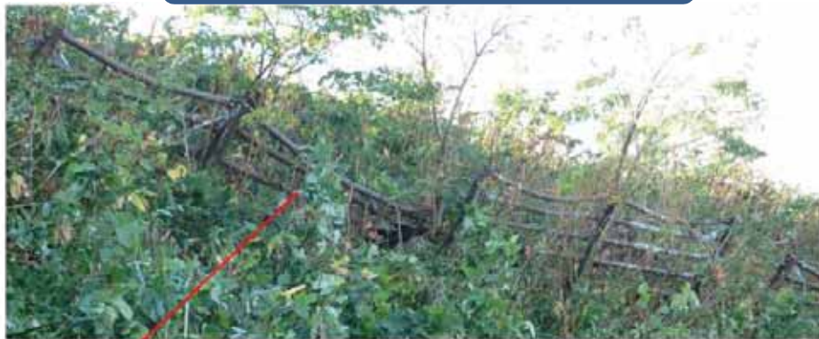
既設雪崩予防柵の腐朽による破損
