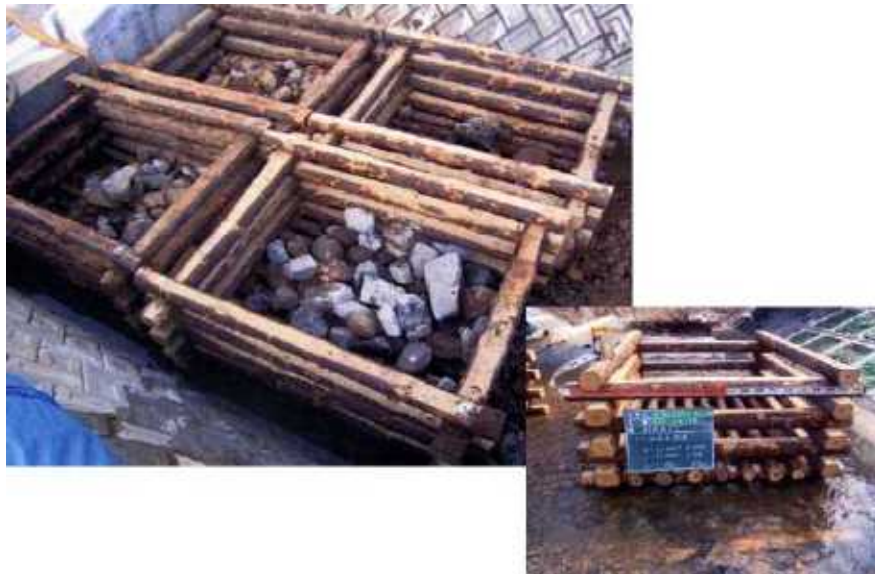
出典：公共土木工事における木材利用事例集
