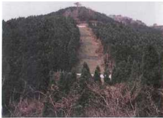
山腹工（施工直後）
