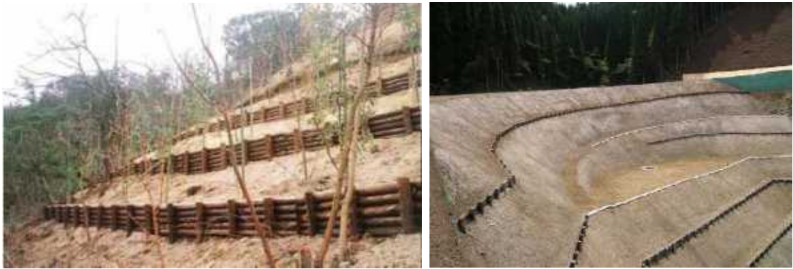
写真 2 小型木製構造物の例（左：木柵工、右：丸太筋工） 出典：公共土木工事における木材利用事例集
