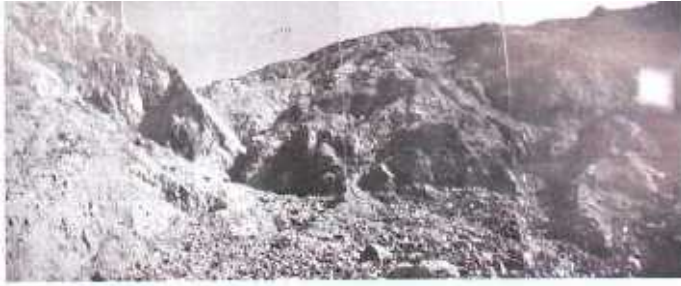
写真-1 荒廃状況 山腹
