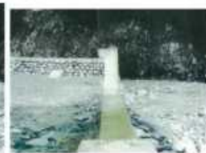
天端補修施工後
