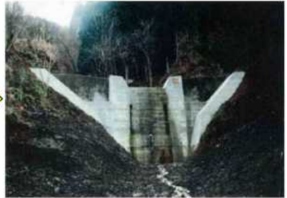
増厚・根継ぎ施工
