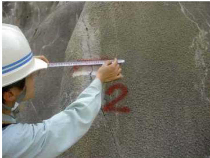
図 10 スプレーによるマーキングの事例
