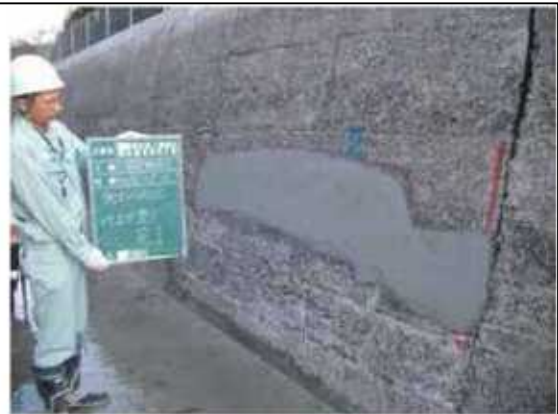
写真 4.2.1-2 断面修復終了後
