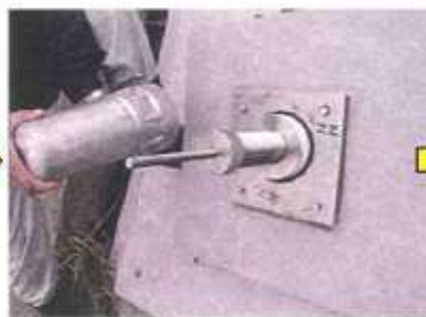
取付け作業中
