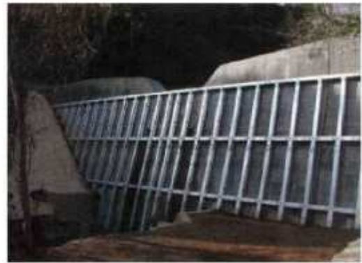
施工後(鋼材補強) 対策実施状況
