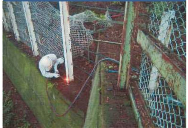
落石による防護網等の損傷
