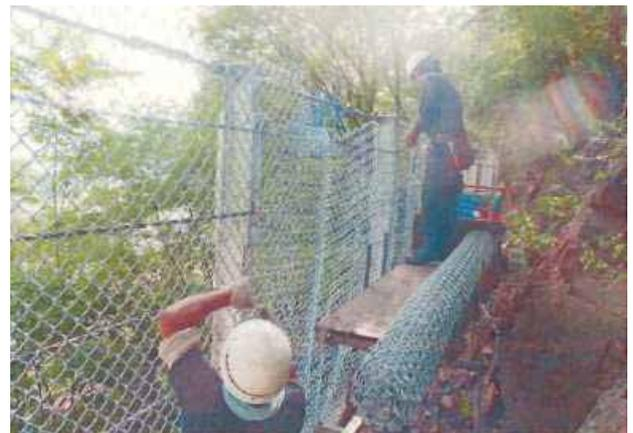
《施工状況（損傷部の撤去・交換）》
