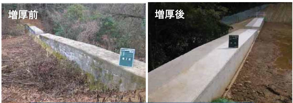
本堤の構造が現在の技術基準による断面より過少であったため、
