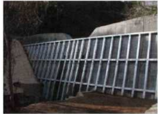
施工後(鋼材補強) 対策実施状況
