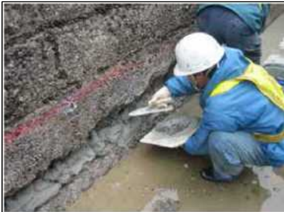
写真 4.2.1-1 断面修復材の充填
