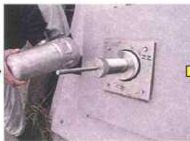
取付け作業中
