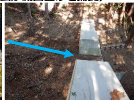
治山ダムが流出土砂を捕捉
