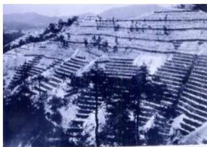
山腹緑化工の施工 大正6(1917)年
