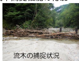
既設治山ダムの上流側に流木捕捉機能を付加する取組
