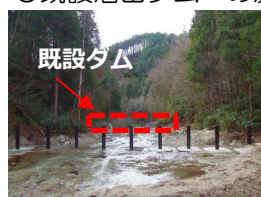
既設治山ダムの上流側に流木捕捉機能を付加する取組
