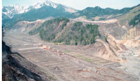
施工中 昭和61(1986)年
