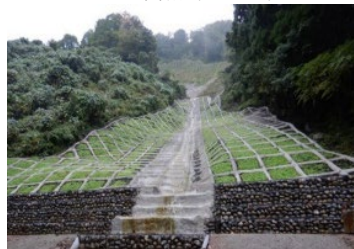
荒廃山地の復旧（山腹工）
