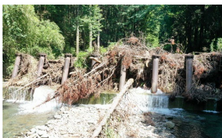
流木捕捉式治山ダムによる流木の流出防止
