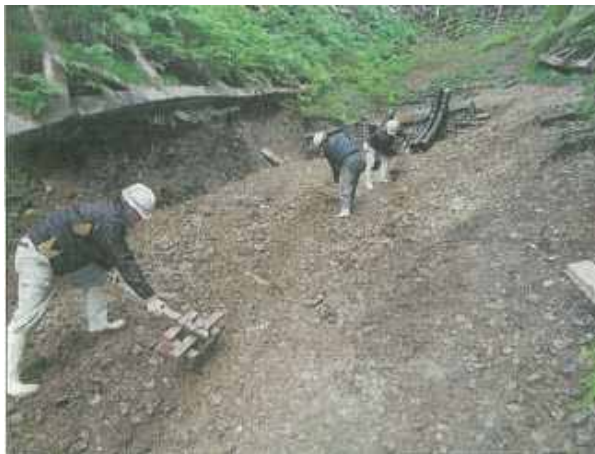
＜法面整形状況＞
