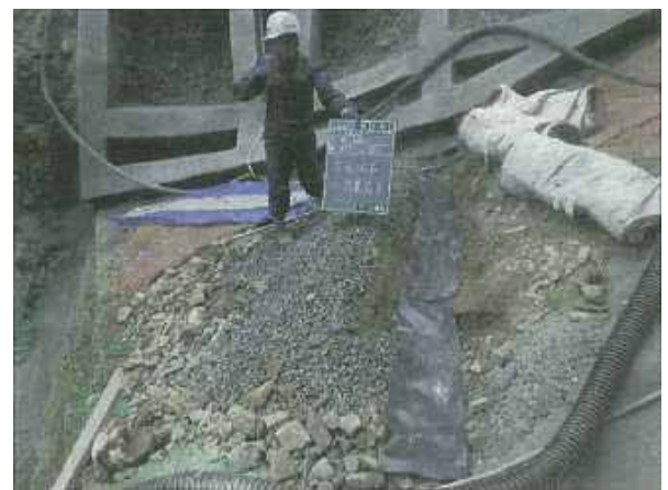
＜防水シート敷設状況＞
