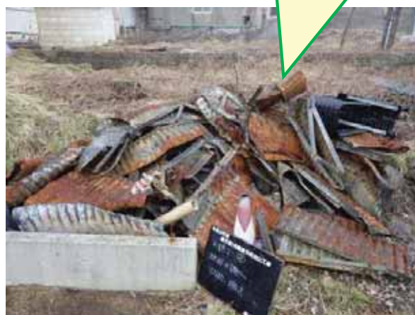
《施工状況（撤去後）》
