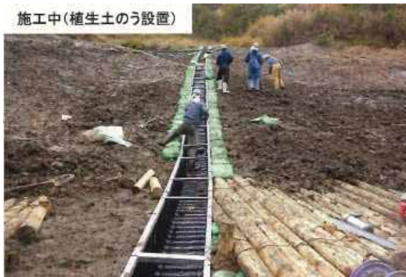
＜植生土のう設置状況＞
