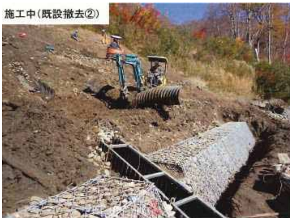
＜既設水路工撤去状況＞
