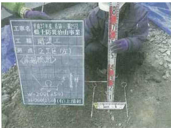
＜水路工の床掘出来型写真＞
