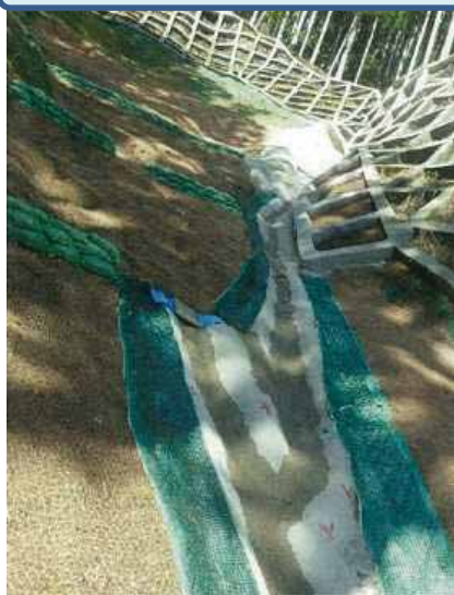
湧水を既設水路工まで導水するため、現場吹付水路工(モルタル)並びに暗渠工を新設
