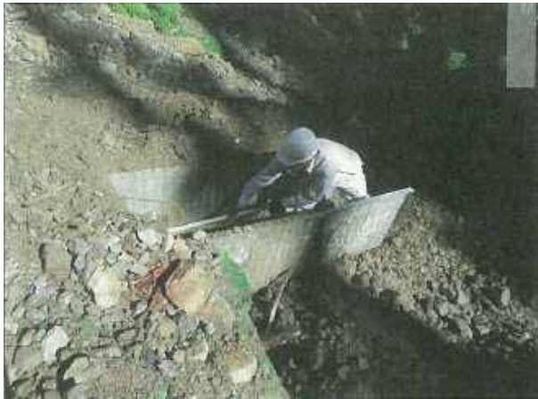
＜堆積土砂除去状況＞
