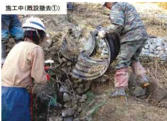
＜既設水路工撤去状況＞
