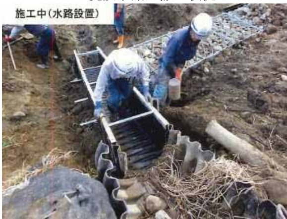
＜角形水路工設置状況＞
