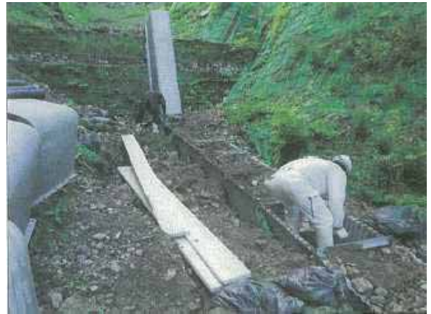
＜堆積土砂除去状況＞
