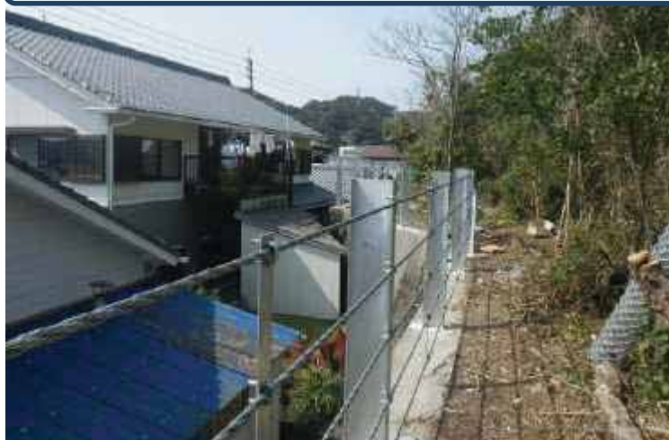
＜防護柵工設置中の状況＞
