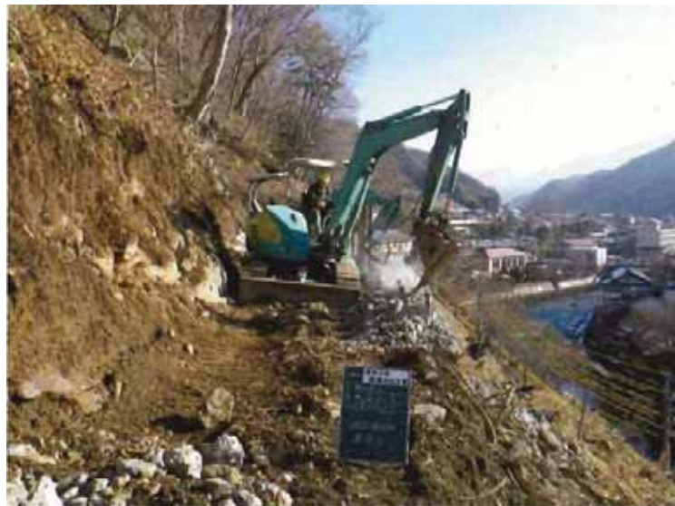
＜基礎コンクリート擁壁取り壊し状況＞
