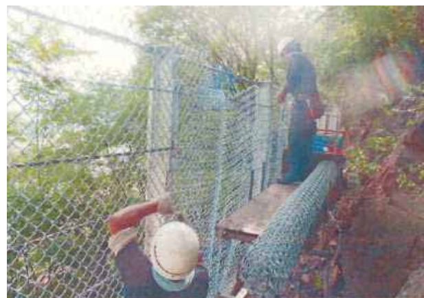
《施工状況（損傷部の撤去・交換）》
