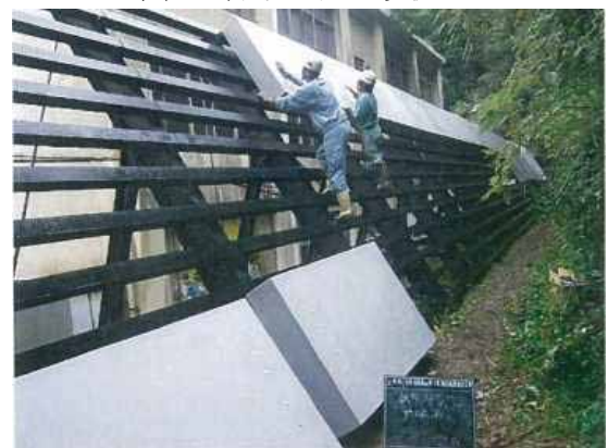
＜緩衝材設置状況＞
