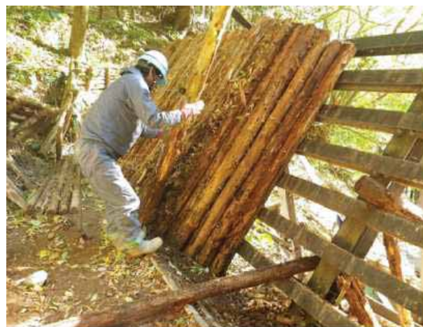
《施工状況（撤去）》
