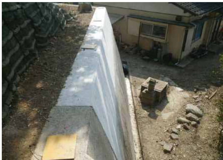
＜コンクリート取り壊し（一部区間）、基礎工設置状況＞
