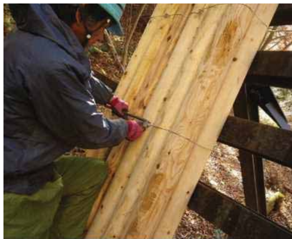
《施工状況（交換）》
