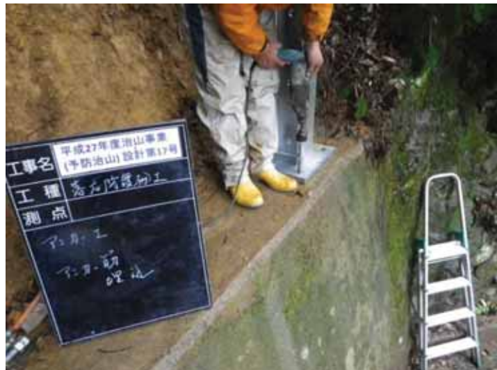
＜アンカーボルト埋込状況＞
