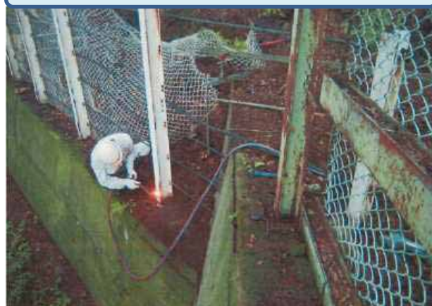
損傷部材の撤去・交換
