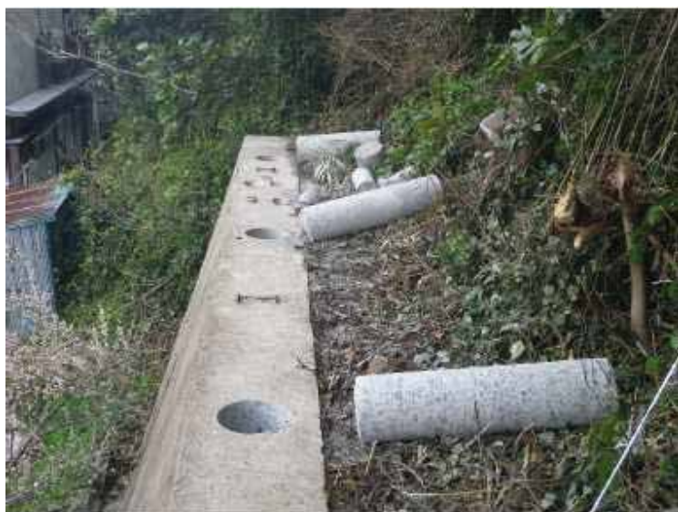
＜支柱穴あけ状況＞
