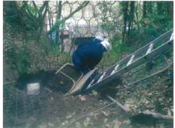
＜堆積土砂の除去状況 4＞
