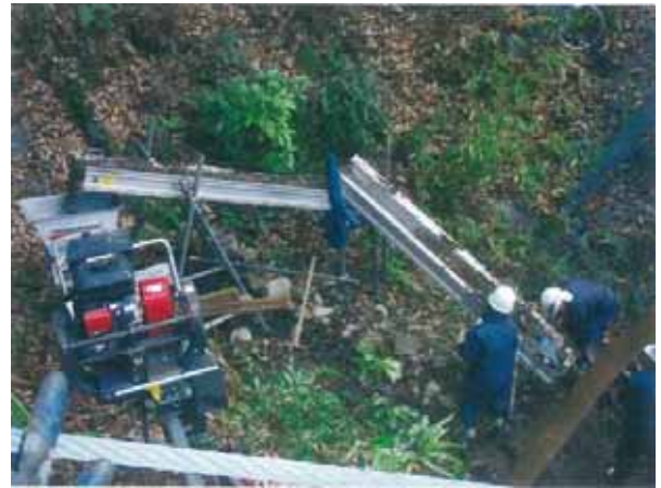
＜堆積土砂の除去状況 2＞
