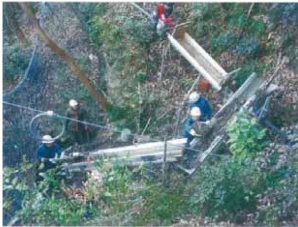
＜堆積土砂の除去状況 1＞
