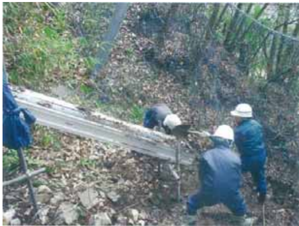
＜堆積土砂の除去状況 3＞
