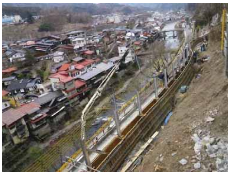
＜コンクリート打設状況＞
