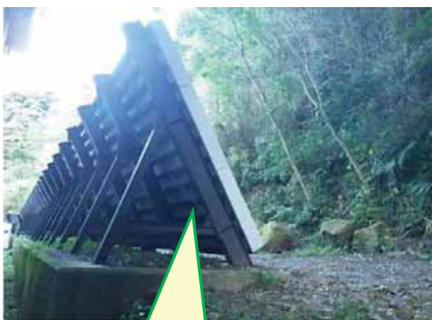
鋼材の交換・塗り替え
