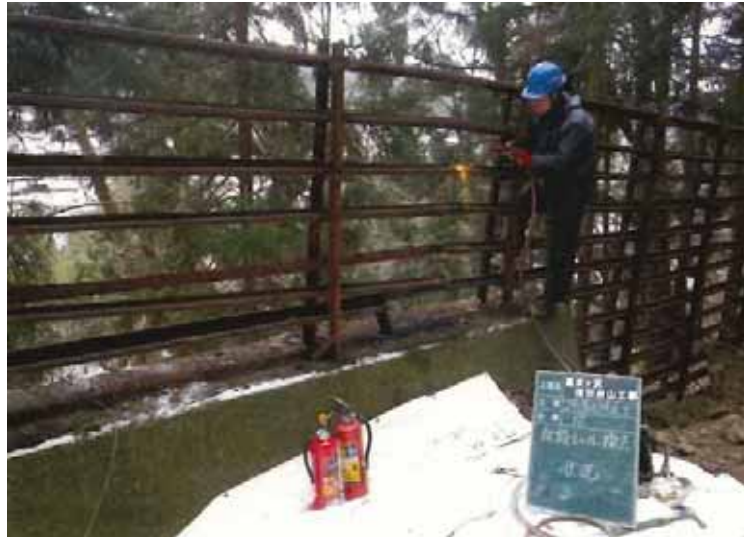
＜レール撤去状況＞
