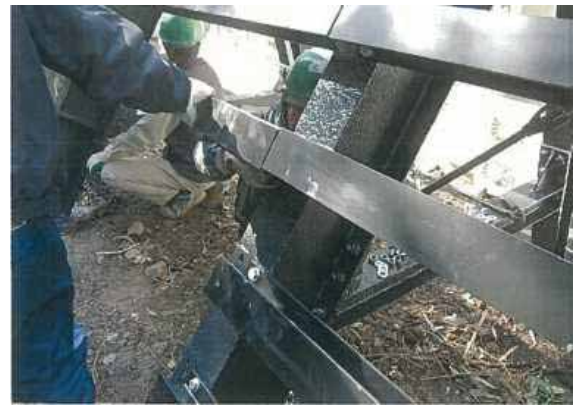
＜鋼製壁材取り付け状況＞
