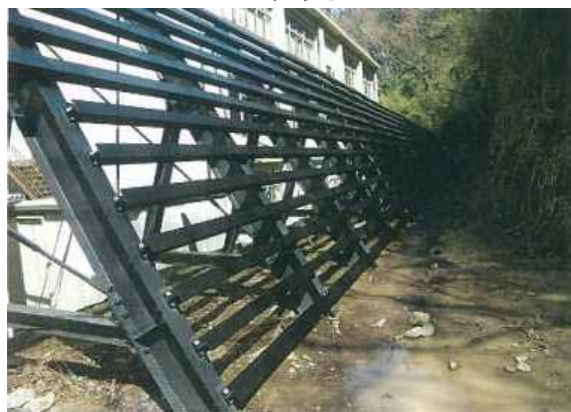
＜鋼製壁材取り付け完了状況＞
