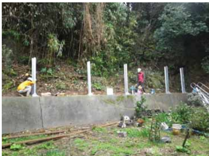
＜アンカーボルト埋込状況＞
