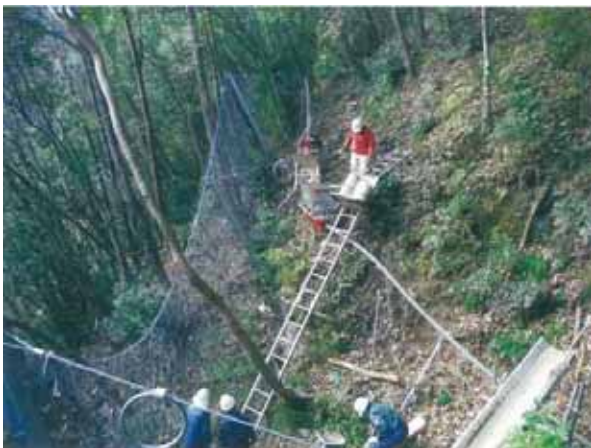
＜堆積土砂の除去状況 5＞
