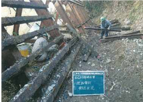
＜既設壁材撤去状況＞
