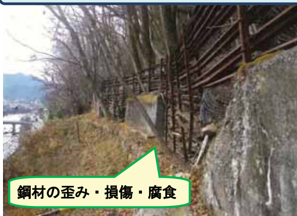
《対策実施前（損傷状況）》
