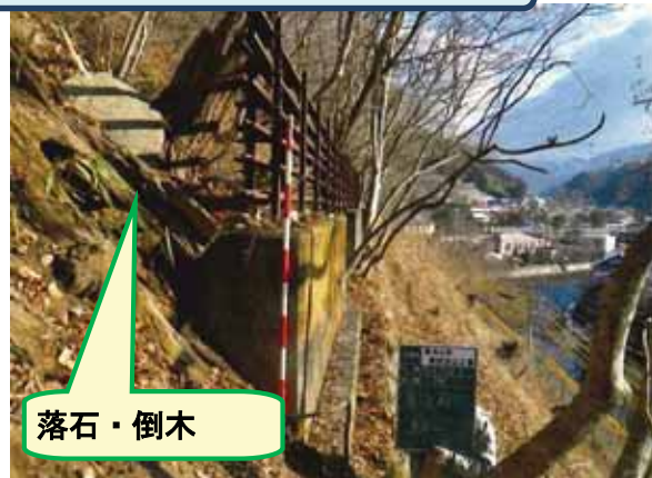
《対策実施前（損傷状況）》
