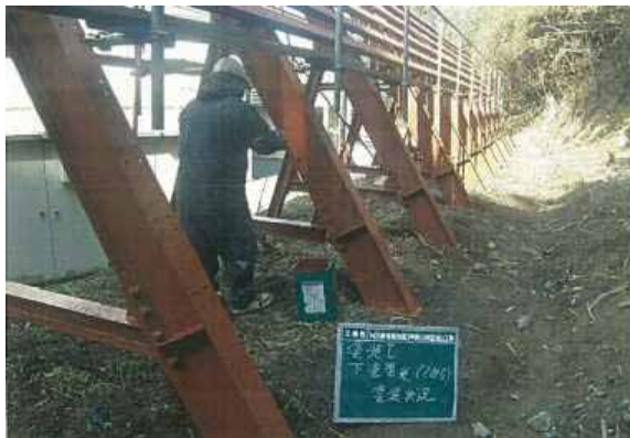
＜下塗塗装状況＞
