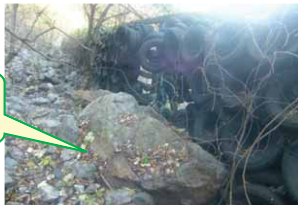
《対策実施前（損傷状況・落石の衝突）》
