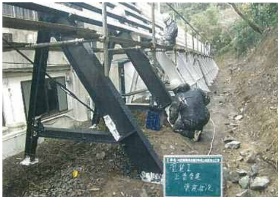
＜上塗塗装状況＞
