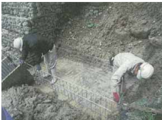
<かご枠工_組立施工状況>
