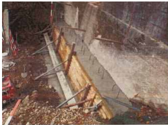
<1 リフト打設後>
