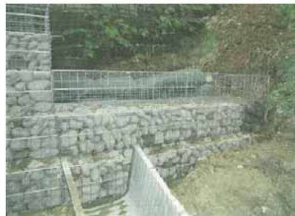
<かご枠工_組立施工状況>
