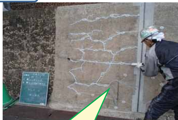
ひび割れ注入作業状況
