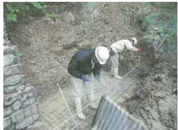
<かご枠工_組立施工状況>
