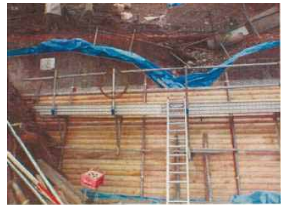
<施工途中・正面状況>
