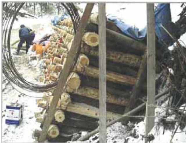
端部施工状況
