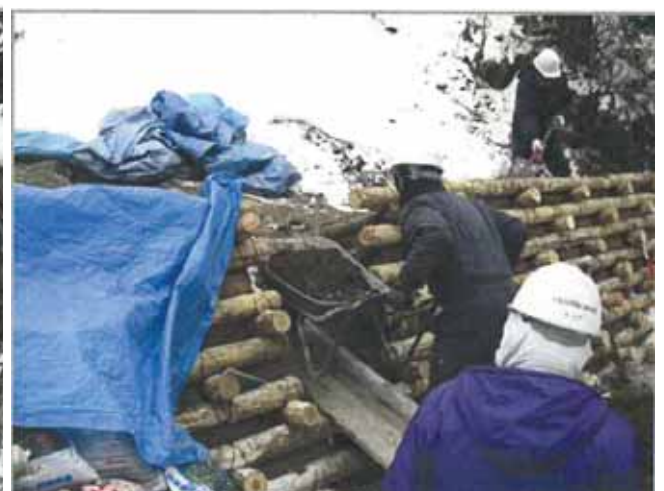
背面盛土状況
