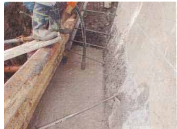
<コンクリート打設>
