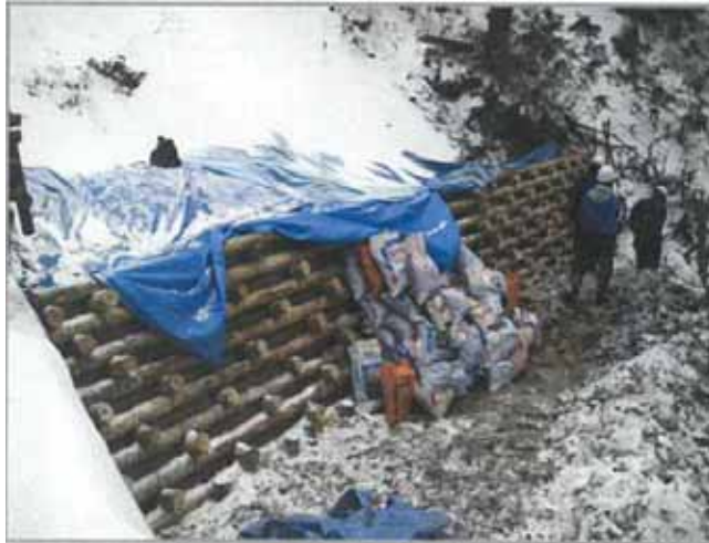
前面部施工状況
