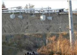
排水施設が適切に設置されていないことによる架台の浸食事例（林地開発許可対象外）
