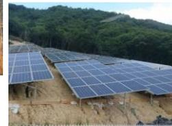
排水施設が適切に設置されていないことによるパネル下の浸食事例（林地開発許可対象外）
