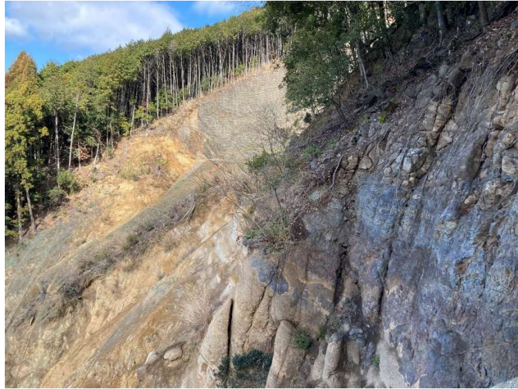
図 87 現地写真：A-7 崩壊地南西側からの遠景 手前の露岩部分では混在岩の様子がわかる
