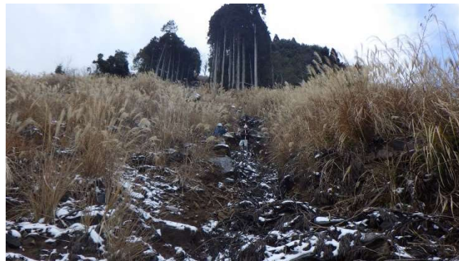
図 80 K-17 崩壊地北東側 斜面上部のスギ林の間から崩壊している
