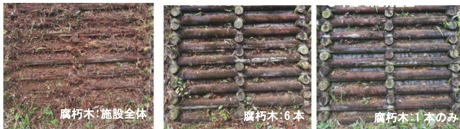
写真-7 10年経過後の木材の状況 (左：無処理、中：加圧のみ、右：圧縮+加圧)
