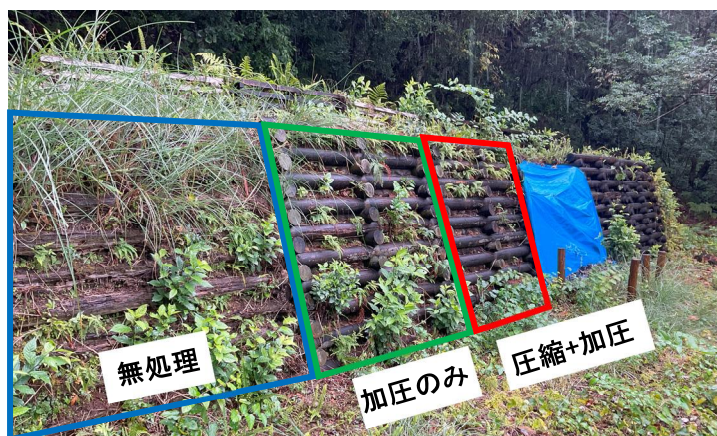
写真 3-8 設置後 13 年が経過した施設の状況
