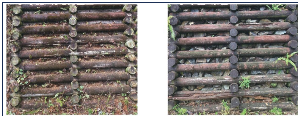
写真 3-5 加圧注入のみの木材の状況 (左：中詰材が土砂 右：中詰材が栗石)
