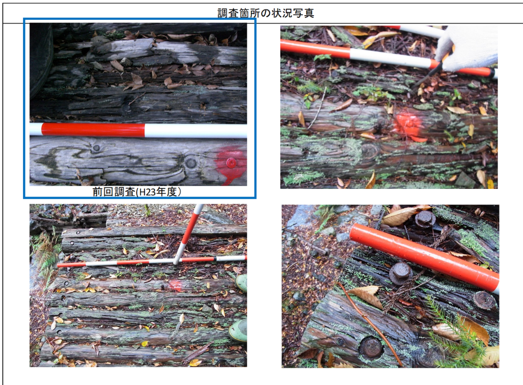
図 3-7 変化の大きかった施設の事例（工種：治山ダム 防腐処理：無し） 前回調査時：施工後 9 年、2 回目調査時：施工後 14 年
