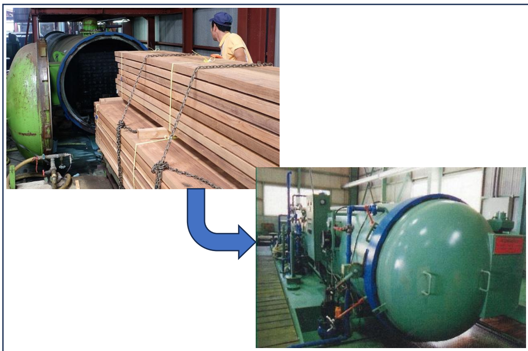
写真 4-4 加圧注入の作業状況
