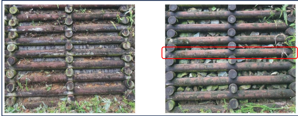
写真 3-6 圧縮処理後に加圧注入した木材の状況 (左：中詰材が土砂 右：中詰材が栗石)
