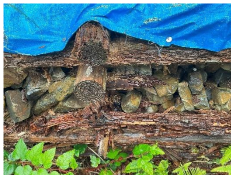
写真 3-10 無処理木材の近景
