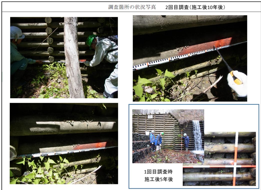
図 3-9 変化の小さかった施設の事例 2 (工種：治山ダム 防腐処理：加圧注入)
