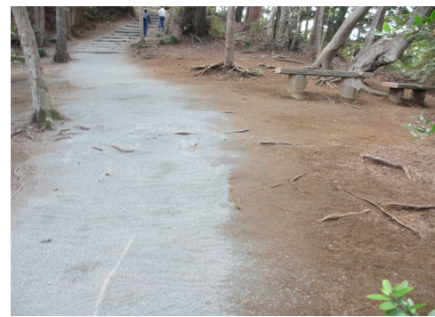
参道の敷き砂
