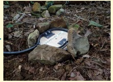
③塩ビ管の上に踏み板をセット
