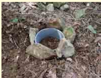
①塩ビ管の周囲に空ハジキ防止の石を並べる
