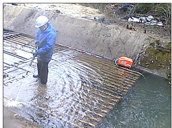
図 4.7 鋼製枠表面石礫の洗浄
