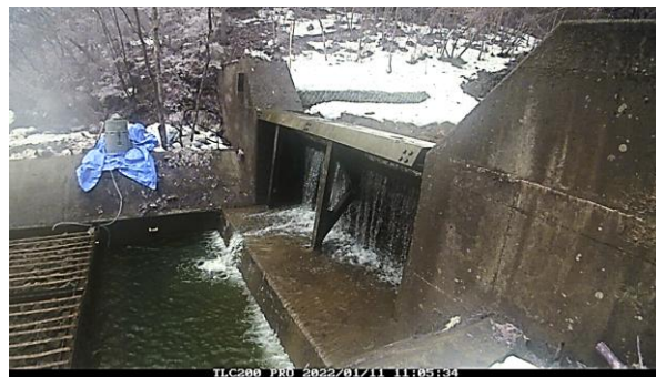
図 4.50 1月11日 11:00 取水桝の濁水が緩和され水中の単管パイプが見えつつある。
