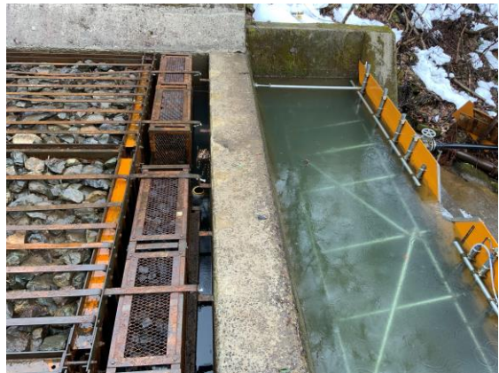
図 4.37 9:30 頃 左:沈砂池が高濃度で濁水化 右:透明度を保つ取水柵の貯留水
