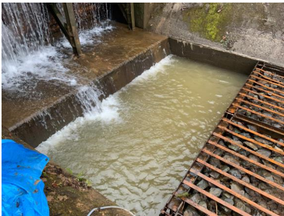
図 4.38 9:40 頃 左:沈砂池の濁水は希釈される 右:止水堤の上段水抜から濁水が流入し、濁り始める
