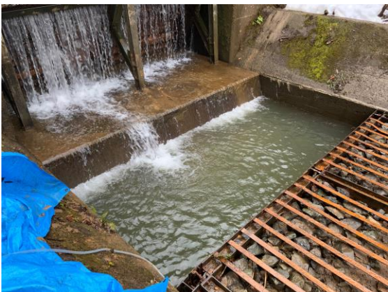
図 4.39 10:00 頃 左:希釈され取水柵と同程度の濁水となる 右:取水柵の濁水がピークを迎える
