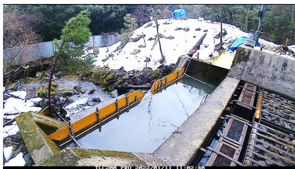
図 4.50 1月11日 11:00 取水桝の濁水が緩和され水中の単管パイプが見えつつある。
