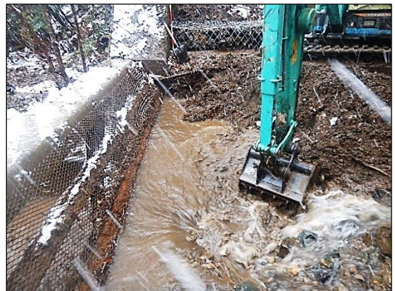
図 4.2 鋼製スクリーンダムの堆砂敷
