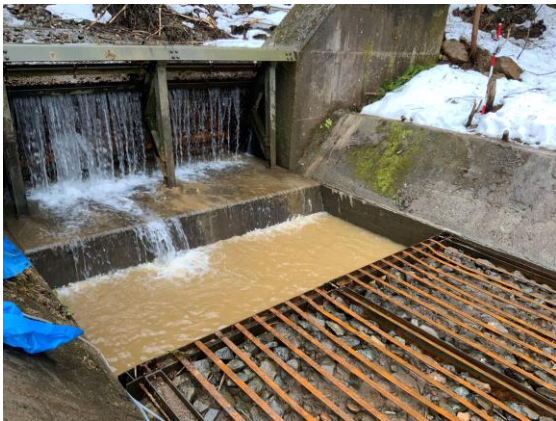
図 4.37 9:30 頃 左:沈砂池が高濃度で濁水化 右:透明度を保つ取水柵の貯留水
