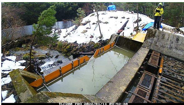
図 4.43 1月11日 9:50 取水栓が濁水化。沈砂池の濁水は希釈され緩和。
