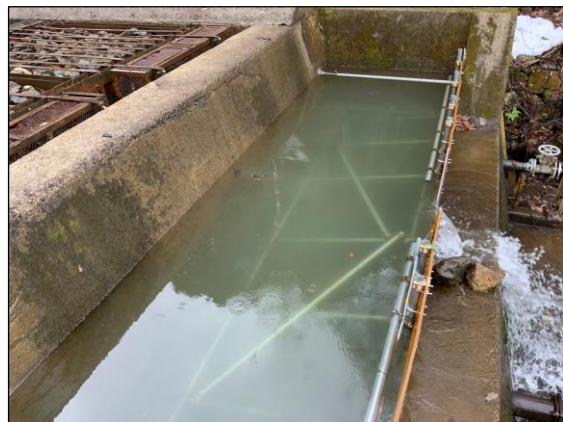
図 4.38 9:40 頃 左:沈砂池の濁水は希釈される 右:止水堤の上段水抜から濁水が流入し、濁り始める
