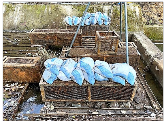
図 4.6 カートリッジ周辺土砂
