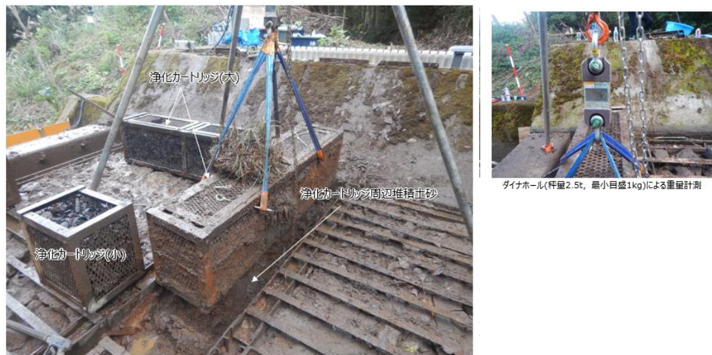
図 4.3 浄化カートリッジの計量状況と計量に活用したダイナホール
