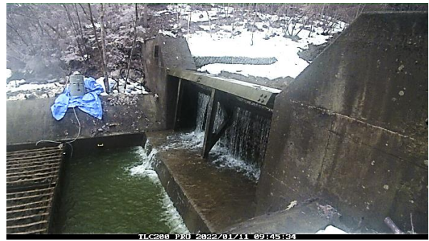
図 4.42 1月11日 9:40 濁水が止水堤の水抜きから取水栓に流入。沈砂池の濁水は希釈。
