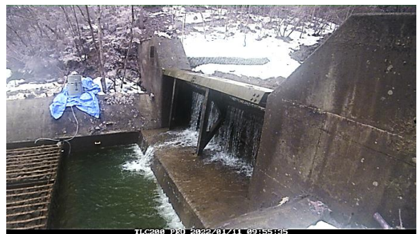
図 4.43 1月11日 9:50 取水栓が濁水化。沈砂池の濁水は希釈され緩和。
