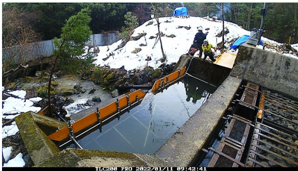
図 4.42 1月11日 9:40 濁水が止水堤の水抜きから取水栓に流入。沈砂池の濁水は希釈。
