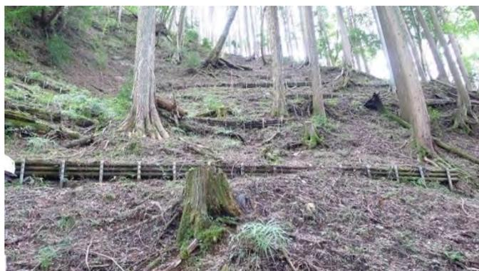
図 2.12 筋工の設置状況
