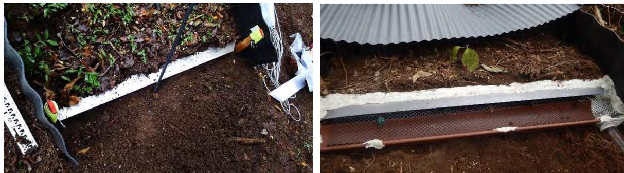
図 3.24 集水部におけるパネルの設置(左)と軒樋とメッシュシートの設置(右)
