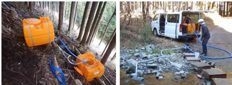
図 3.36 給水タンクの配置と水の確保
