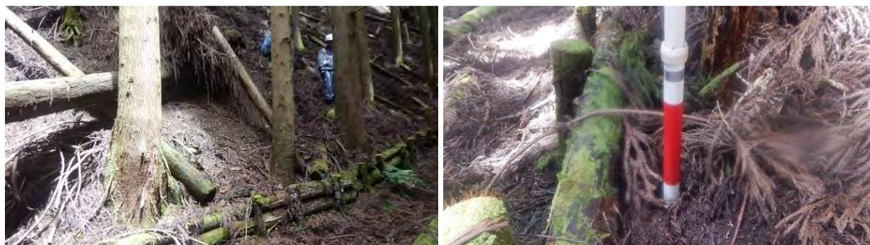
付図 18 根返りした際の土砂が筋工の背面に堆積している。
