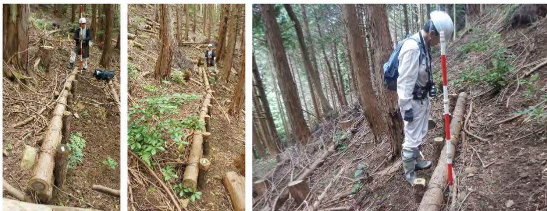
付図4 筋工の設置状況(ヒノキの鱗片や枝条を捕捉。また小～中礫も捕捉)
