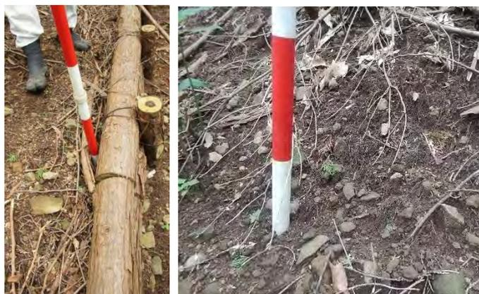
付図5 筋工の背面と接続する地山部分(ヒノキの細根が露出)
