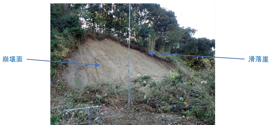
写真 1.2 崩壊地の崩壊面と滑落崖（千葉県富津市）
