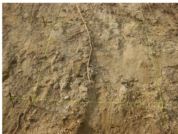
写真 1.3 崩壊面の調査ブロック
