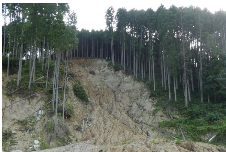
写真 1-3 2017 年、九州北部豪雨災害で発生した花崗岩地帯、スギ壮齢林内の崩壊地
