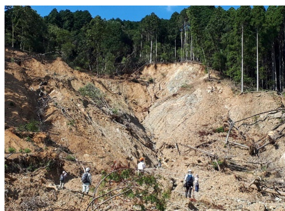
写真 2-4 三郡変成岩分布域で見られた深い崩壊
