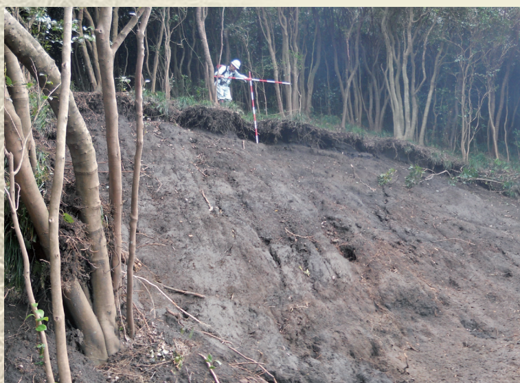
平成25年伊豆大島土砂災害
