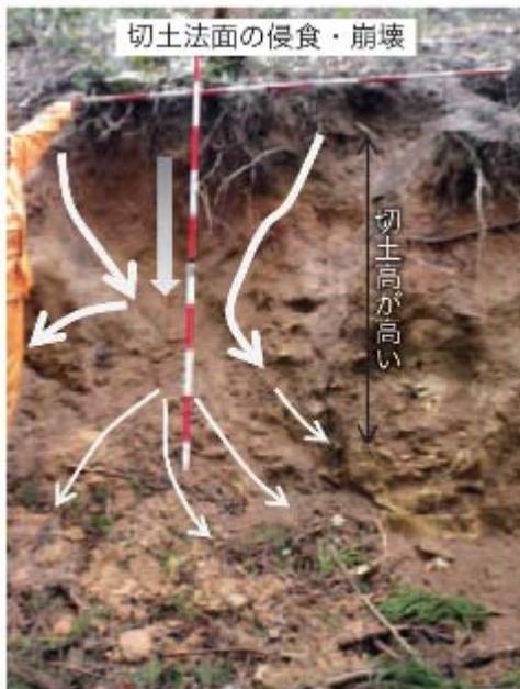
写真：切土法面の侵食・崩壊
