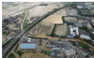
桂川における浸水被害
