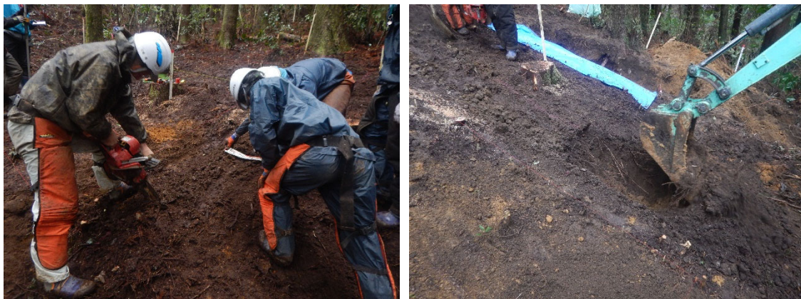
図 2.39 H25-26 の立木間中央から 40cm 離れて根系を切断し、重機で作業空間を確保。
