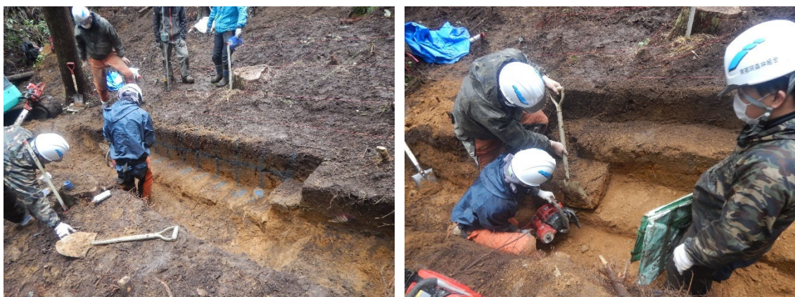
図 2.45 根切りチェーンソーを活用し階段状に切り進める。ブロックが分解する場合、スコップで固定。
