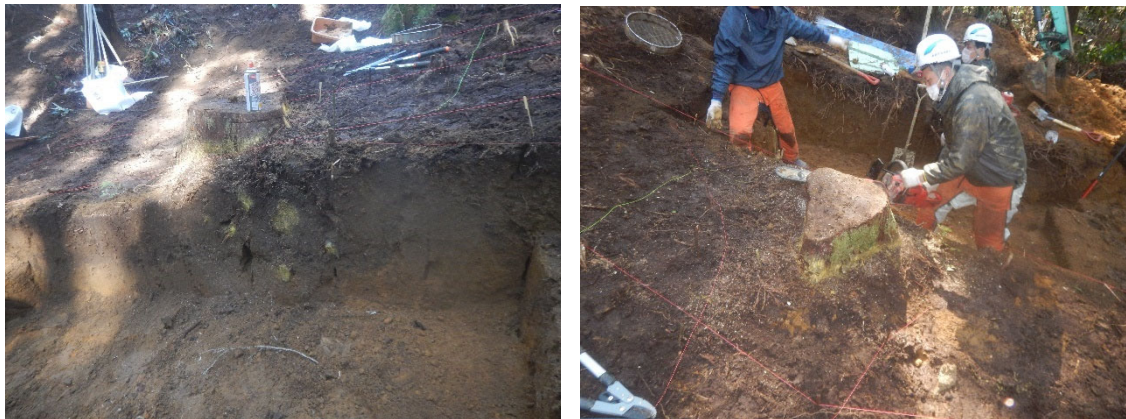
図 2.49 伐根近接部の断面と伐根地上部の除去。
