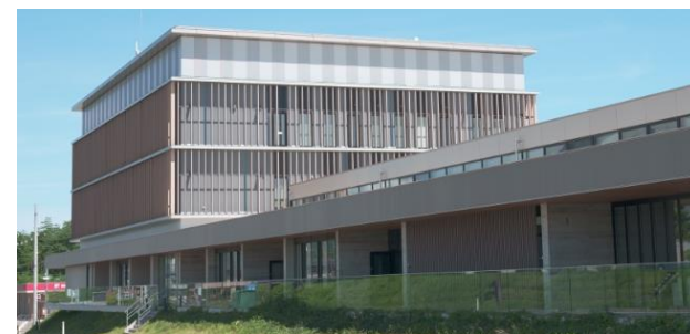
主要な建材にFSC認証材である町産スギ材を使用した南三陸町役場 外観
