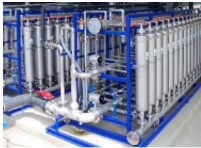
エンジニアリング 排水処理プラント設置・運営
