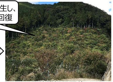
防護柵設置後
