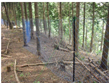
防護柵（ネット）滋賀県
