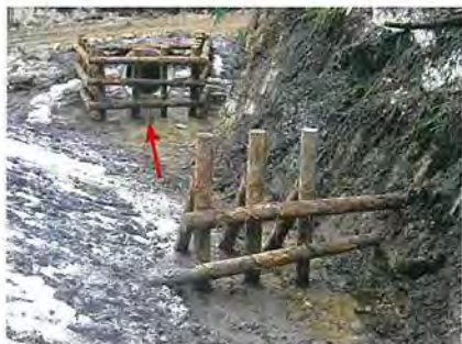
呑口保護工・流木除け工
