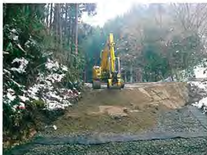
路床工・盛土工
