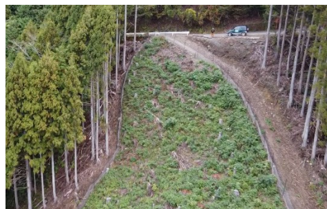
写真1 ドローンによる柵破損や苗木枯損の確認
