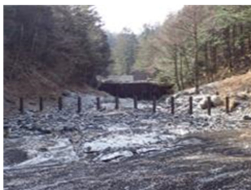
写真－３ 流木止工（鋼管建込型）
