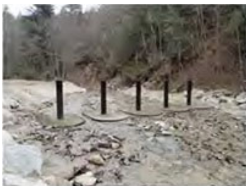
写真－２ 流木止工（独立基礎型）
