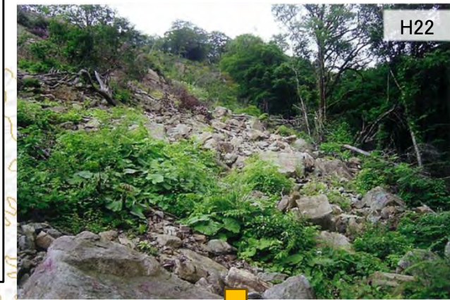
【②真湯 復旧状況】
