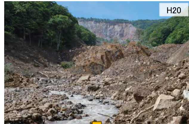
【①産女川上流 溪間工整備状況】
