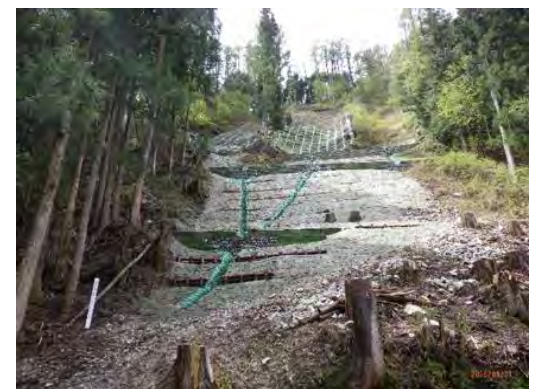
④押の沢区域における山腹施工(R7年度)
