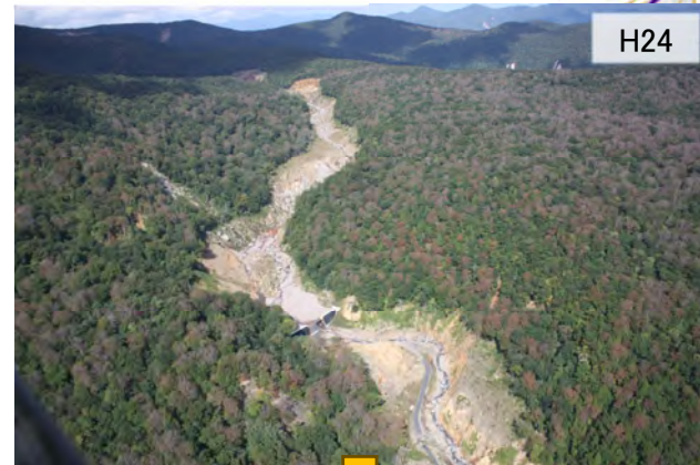
【①ドゾウ沢 復旧状況】
