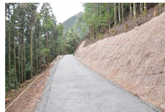
路網開設（滑沢支線林業専用道）
