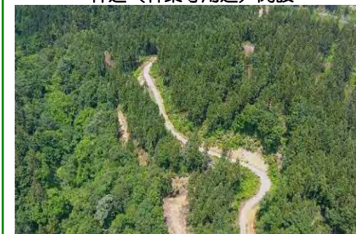
林道（林業専用道）開設
