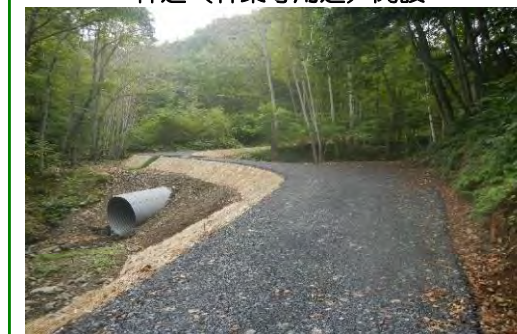
林道（林業専用道）開設
