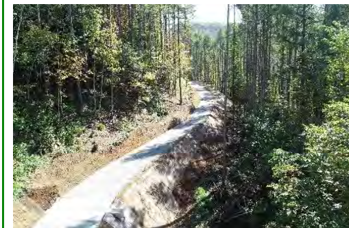
林道(林業専用道)開設
