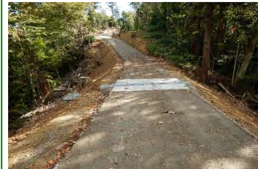
林道(林業専用道)開設
