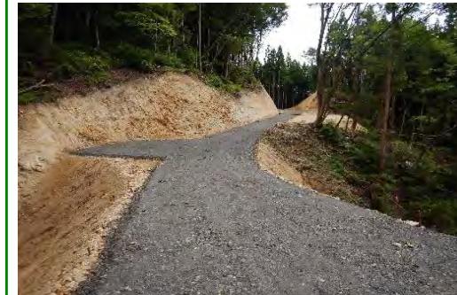
林道（林業専用道）開設
