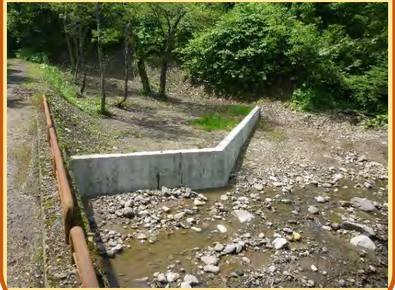
林道改良工事
