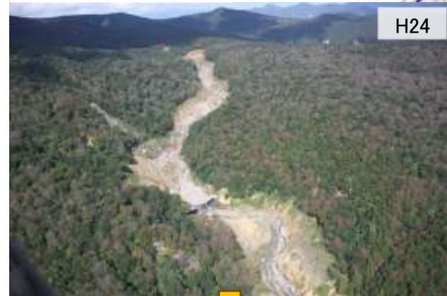
【①ドゾウ沢 復旧状況】
