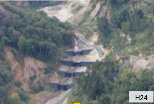
【①シヅミクキ沢 復旧状況】
